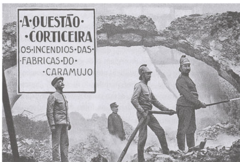
Os bombeiros combatendo os incêndios na fábrica da cortiça Villarinho, na noite de 22 para 23 de Agosto de 1911. (Col. I. P.).
