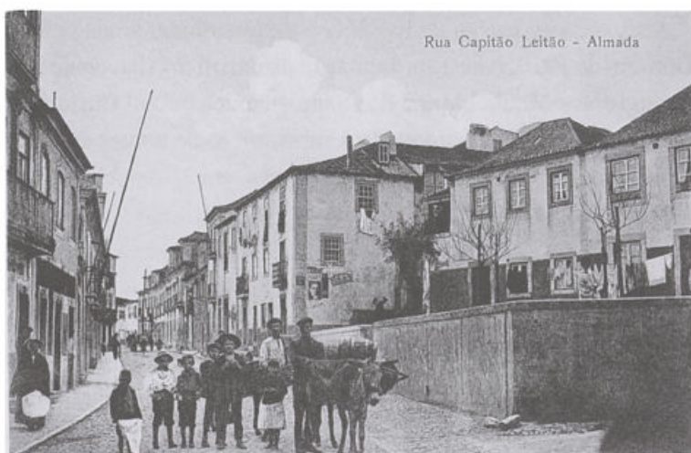
Rua Capitão Leitão, antiga Rua Direita de Almada.
